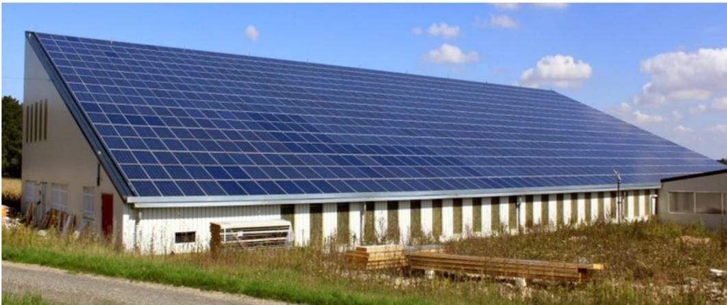
*Figura 7 - Impianto solare fotovoltaico su copertura edificio ad uso agricolo*
