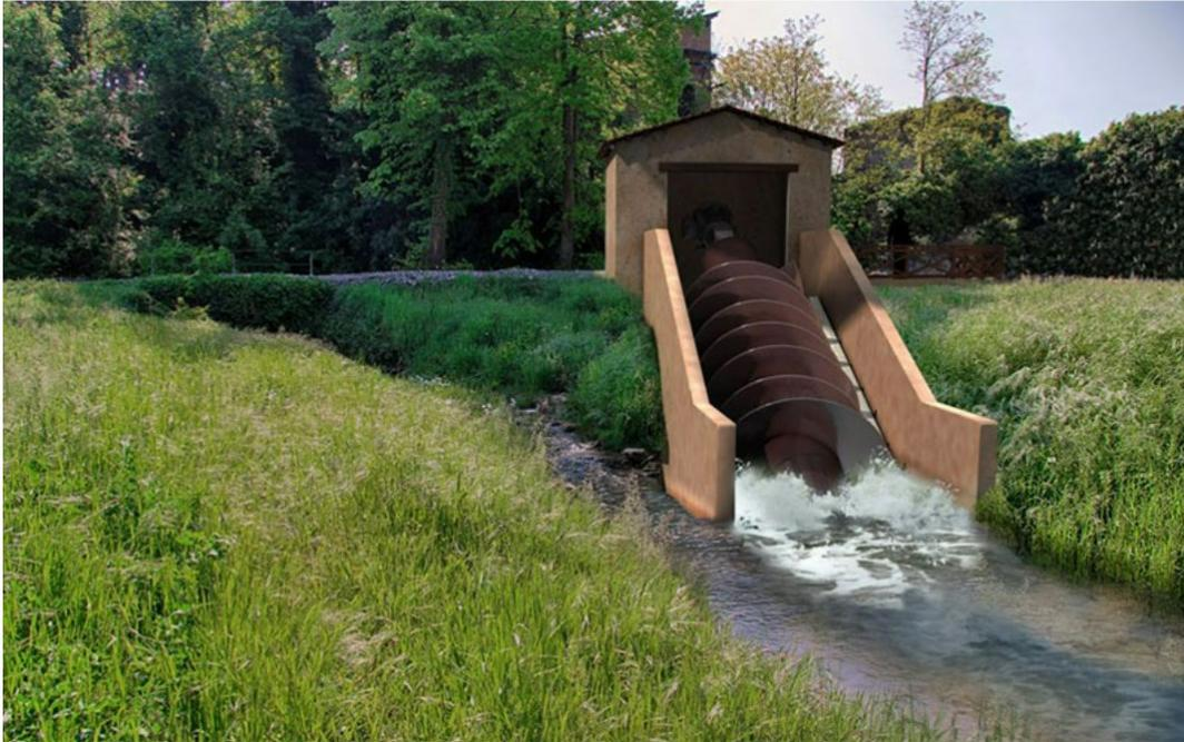
*Figura 8 - Mini idroelettrico in azienda agricola. Fonte: [www.studiocanepa.it](http://www.studiocanepa.it)*
