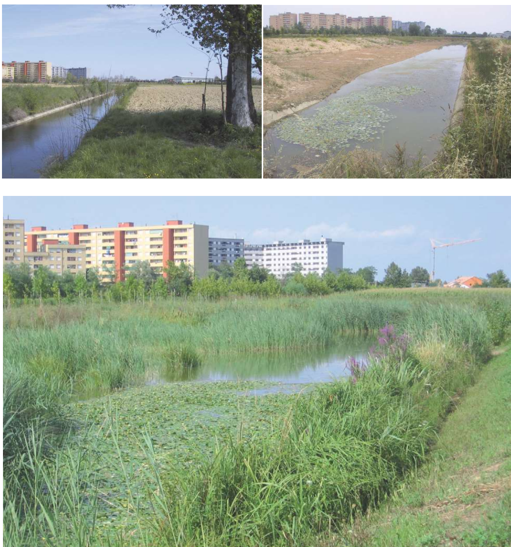
Allargamento di sezione del Collettore Favaro e creazione di golene allagabili colonizzate da vegetazione palustre (Consorzio di bonifica Acque Risorgive).
