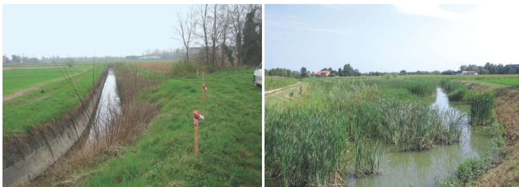
Costruzione di una zona umida in alveo lungo la Fossa Pagana. A sinistra: il canale prima della realizzazione degli interventi di riqualificazione. A destra: allargamento e rimodellamento della sezione al fine di costruire la zona umida in alveo (Consorzio di bonifica Acque Risorgive).
